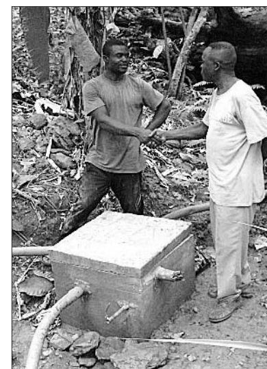
Der Auffang-Behälter für das Quellwasser mitten im Urwald: Eine 2,5 km lange Leitung wurde verlegt.
